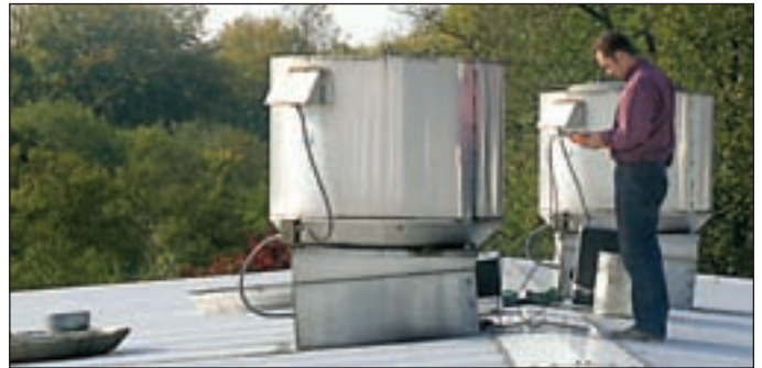
Bild 3: Messungen auf dem Gebäudedach einer Produktionshalle
