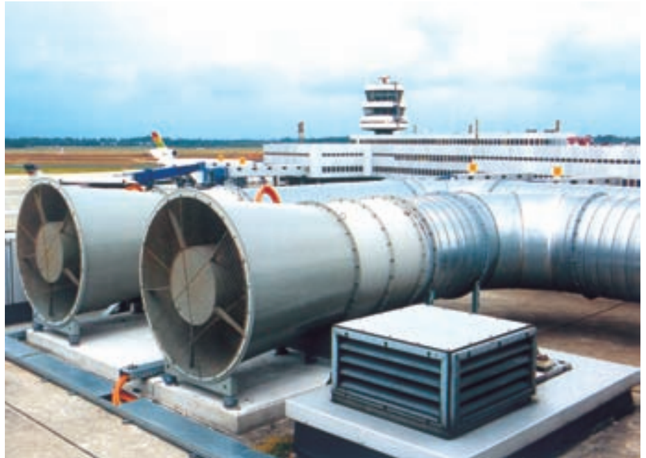
Flughafen Düsseldorf: Blechkanal zum Schutz der elektrischen Leitungsanlagen vor mechanischer Beschädigung
