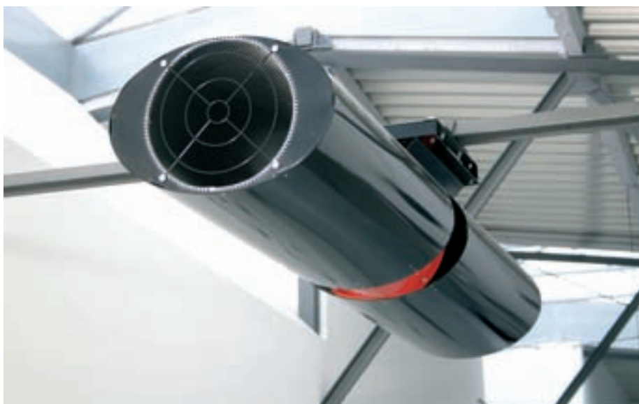
Bild 12: Jet-Ventilator mit ovalem Ansaug- und Ausblassehalldämpfern; TLT-Turbo GmbH, Bad Hersfeld
