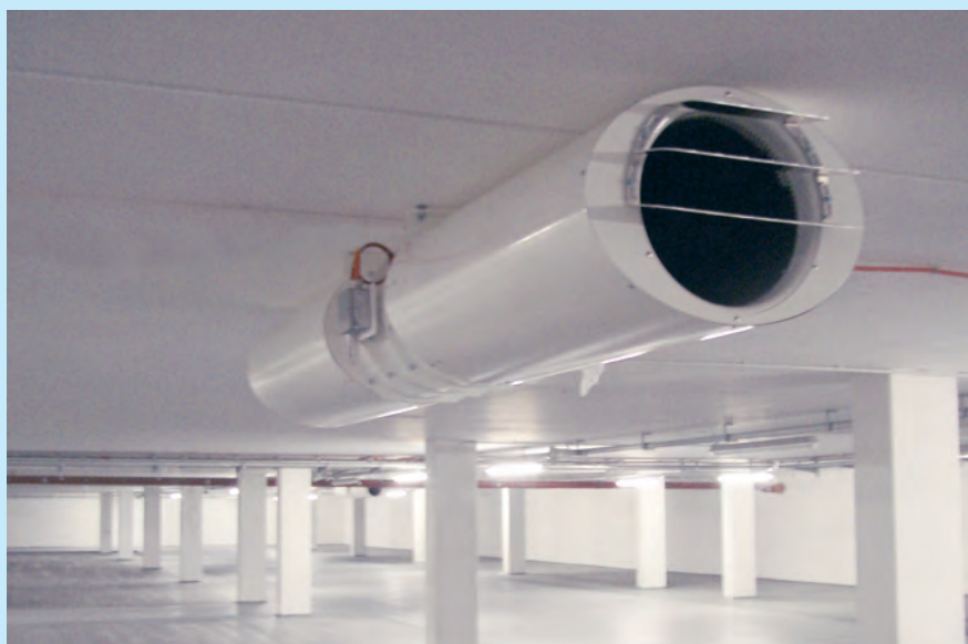
Entrauchungs-Jet-Ventilatoren Typ BVGAXR 400 - F 300 (Tiefgarage Hyundai in Offenbach)
