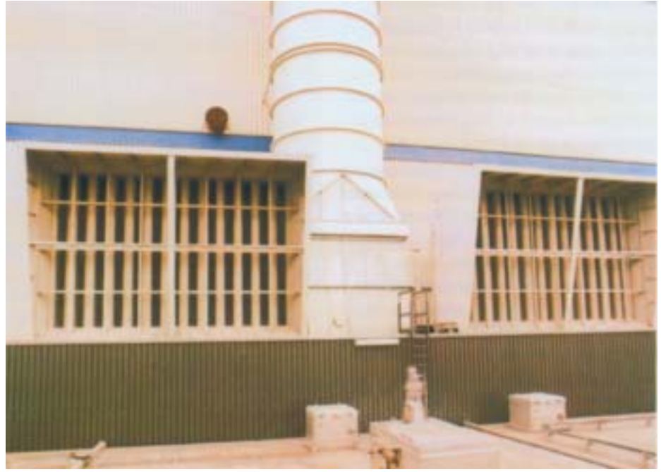
Saug-Schalldämpfer für die Außenab-saugung eines dreistufigen Absorp-tions-Schalldämpfers für ein Frischluft-Gebläse ( \dot{V} = 433 \text{ m}^3/\text{s} , \Delta p_i = 8250 \text{ Pa} ) in einem Kraftwerk. Auslegung auf \dot{V} = 60\% Dämpfung auf 70 dB (A)
