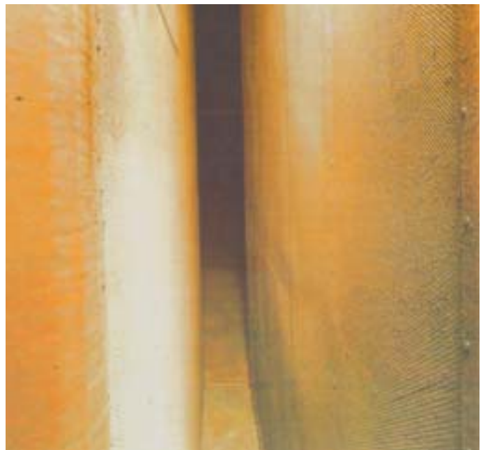
Unten: Großaufnahmen von Absorptions-Kulissenwänden nach ca. 11 000 Betriebsstunden.
