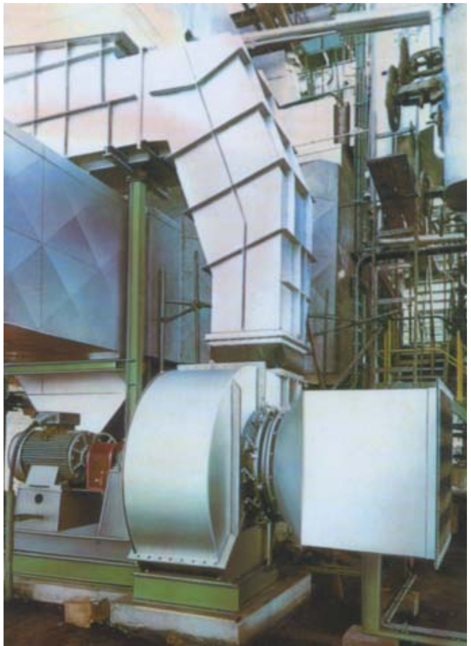
Radial-Frischluf-Gebläse mit Drallregler und Ansaugdämpfer ▶
